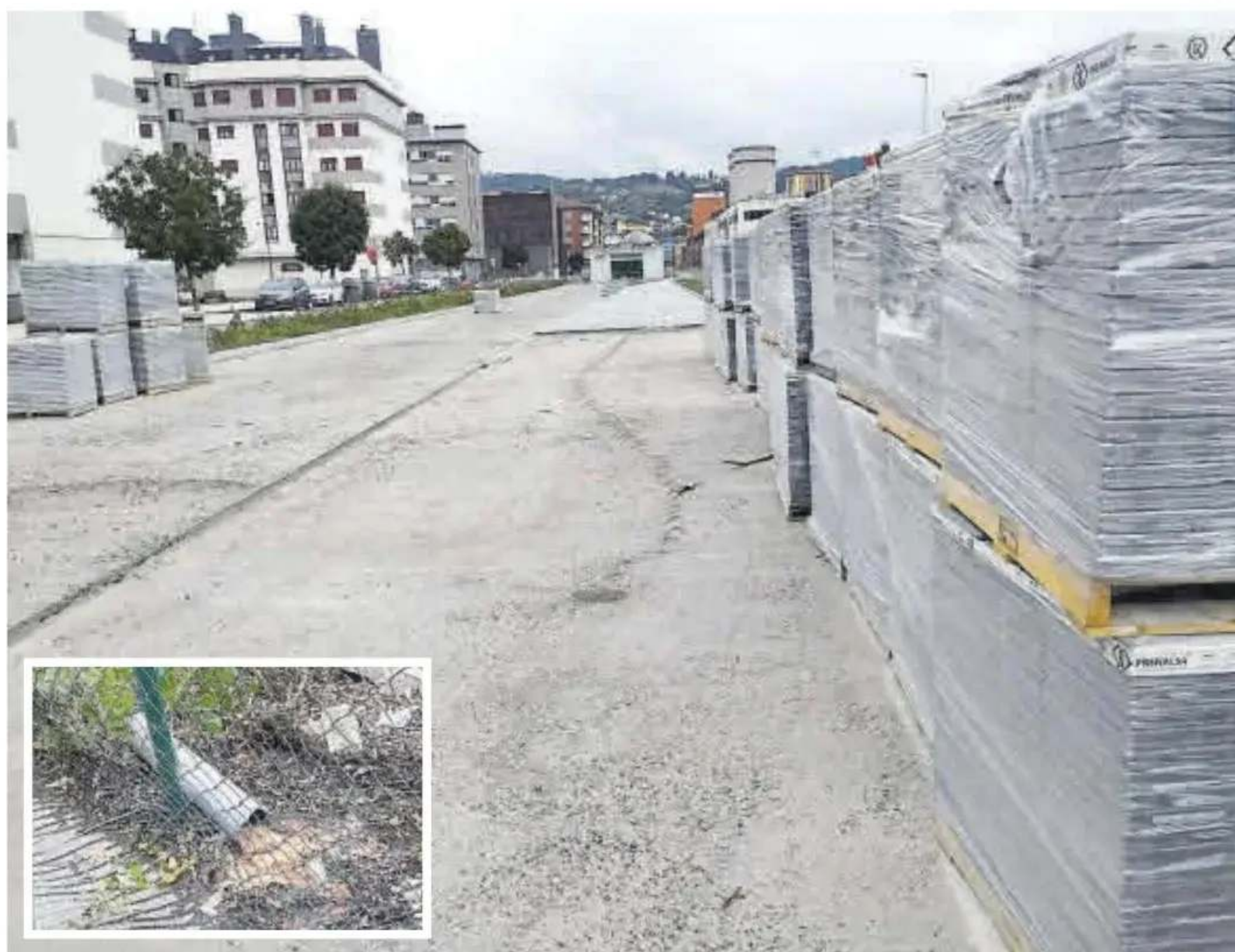
Materiales para la urbanización del soterramiento. En el recuadro, la tubería de los vertidos denunciados.
